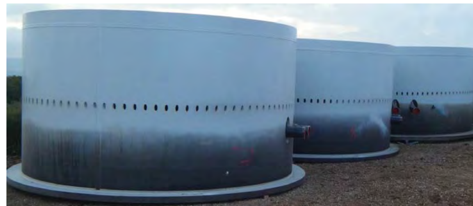
Photo 9 : Couronnes métalliques (ou insert) assurant la transmission de charges
