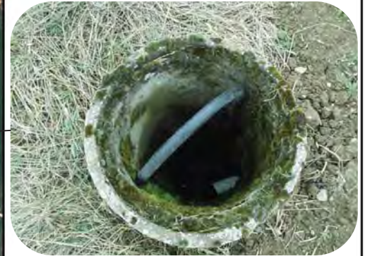
Ouvrage de collecte des eaux
