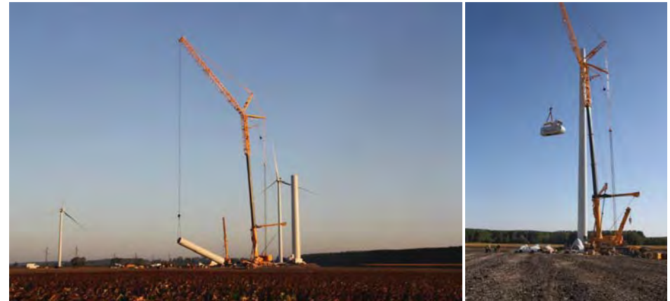
Photo 13 : Montage d'un mât et d'une nacelle © Eurocape New Energy
