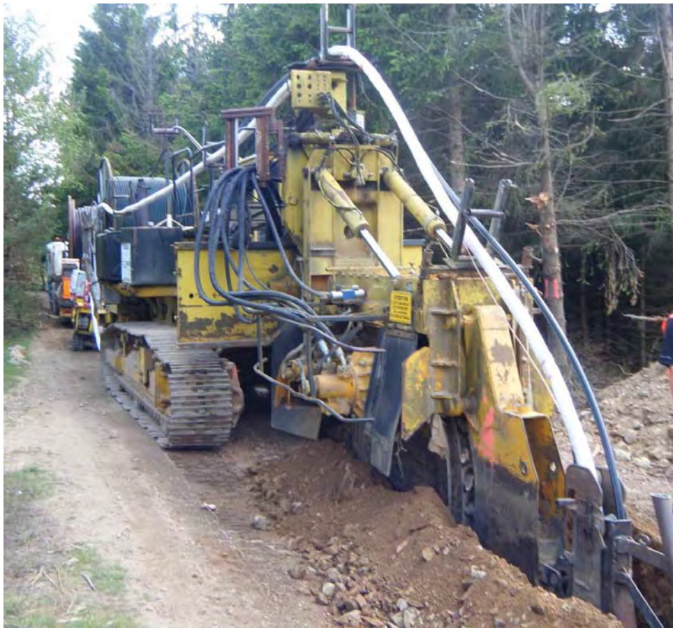
Photo 11 : Trancheuse en action pour le raccordement d'un parc éolien dans l'Allier
