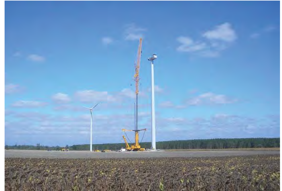
Photo 7 : Chantier éolien © Eurocape New Energy
