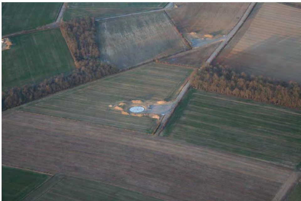
Photo 10 : Une fondation terminée © Eurocape New Energy
