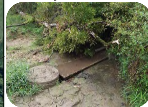
Ouvrage de collecte des eaux
