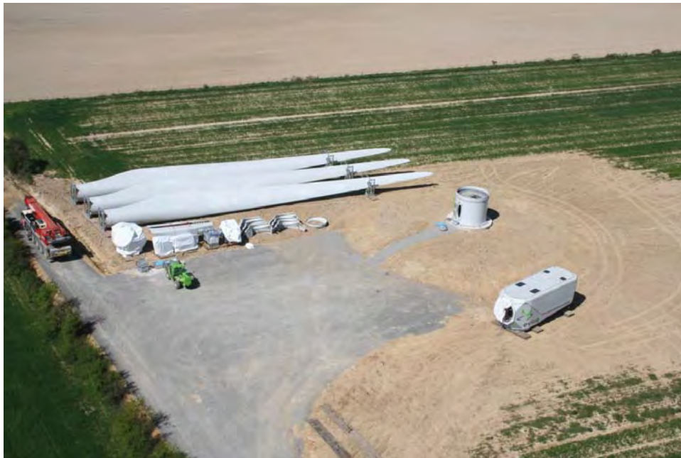
Photo 12 : Stockage des pales et d'une nacelle © Eurocape New Energy
